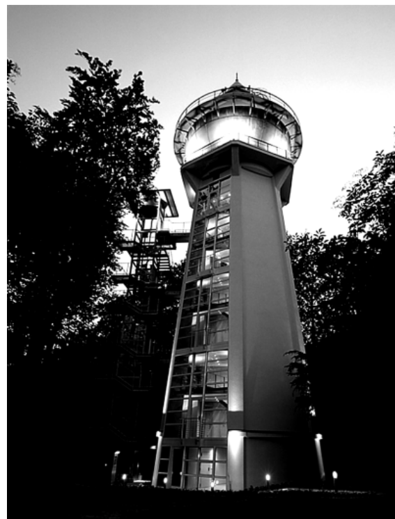
Essen-Bredeney Umnutzung 2002 als Wohn- und Büroturm
