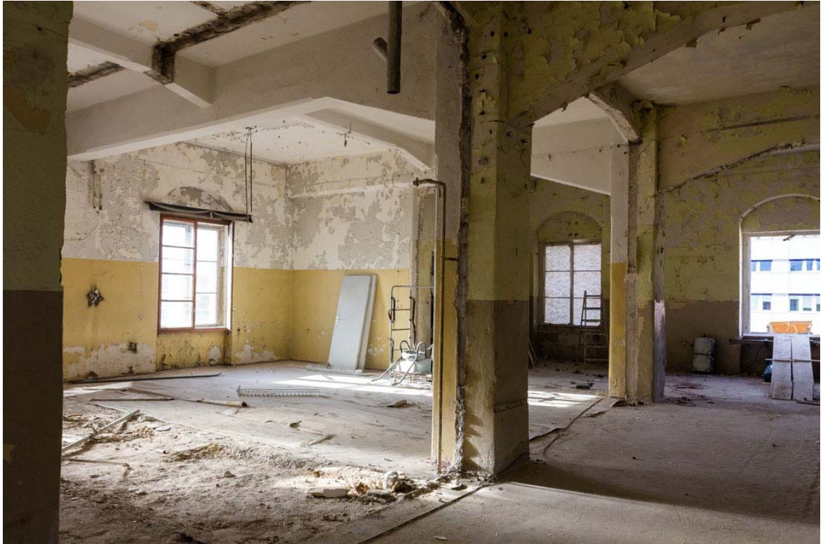
vor der Sanierung
